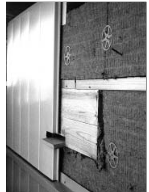
Abb. 2 Fledermauskasten in Dämmfassade
